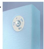
外断熱材の施工では多くの場合、断熱材をビスだけや 釘だけまたは両面テーブなどで仮押さえされています。 しかし、このような仮押さえではかなり不安定です。
